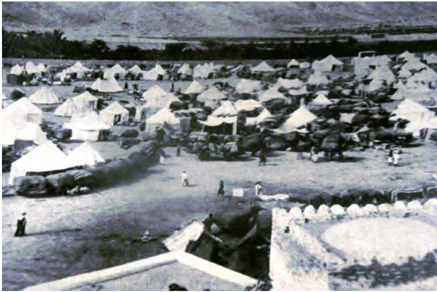
صورة قديمة لمخيم الحجاج بذي طوى وفي الطرف الأيمن يظهر سطح البناء القائم على بئر طوى
